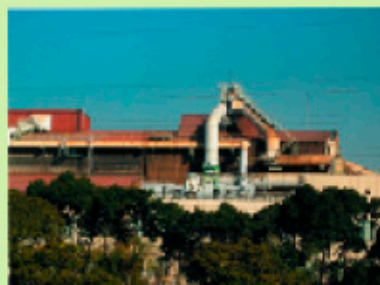
電気炉集じん機の改善
