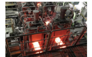
CO 2 排出量削減に向け開発中の小断面連続造化設備
