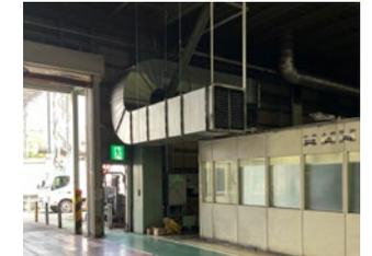
暑熱対策(気化式冷風機器)
