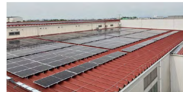
太陽光パネル(東浦工場)
