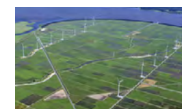
十三湖風力発電所
