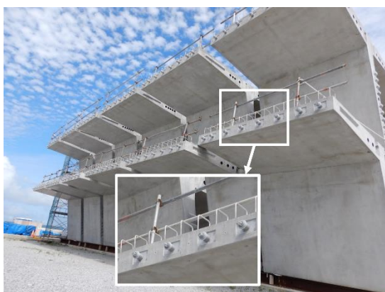
ステンレス鉄筋の適用事例 沖縄県泡瀬橋梁整備工事 地覆鉄筋
