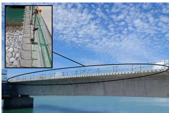
ステンレス鉄筋の適用事例 沖縄県泡瀬橋梁整備工事 地覆鉄筋
