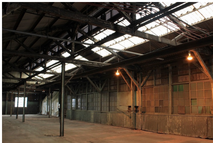
愛知製鋼(株) 刈谷工場 旧試作工場 内部
