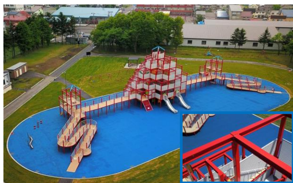
ベルパークちっぷべつに設置されている キュービックコネクション
