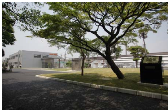
旧事務本館跡地を緑化（奥に見えるのが新事務所）
